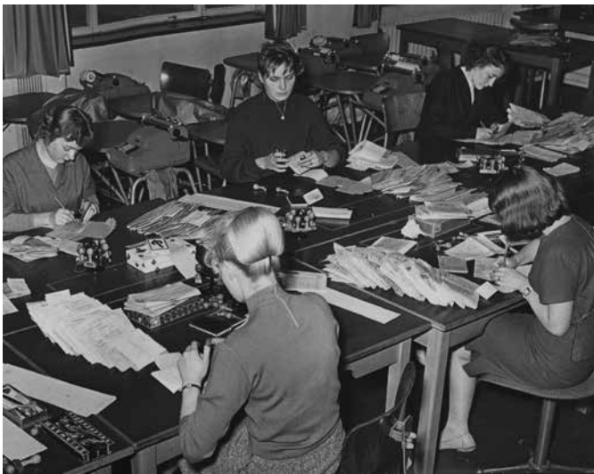
Verteil- und Sonderlistenstelle beim Postscheckamt Dortmund, 1958
